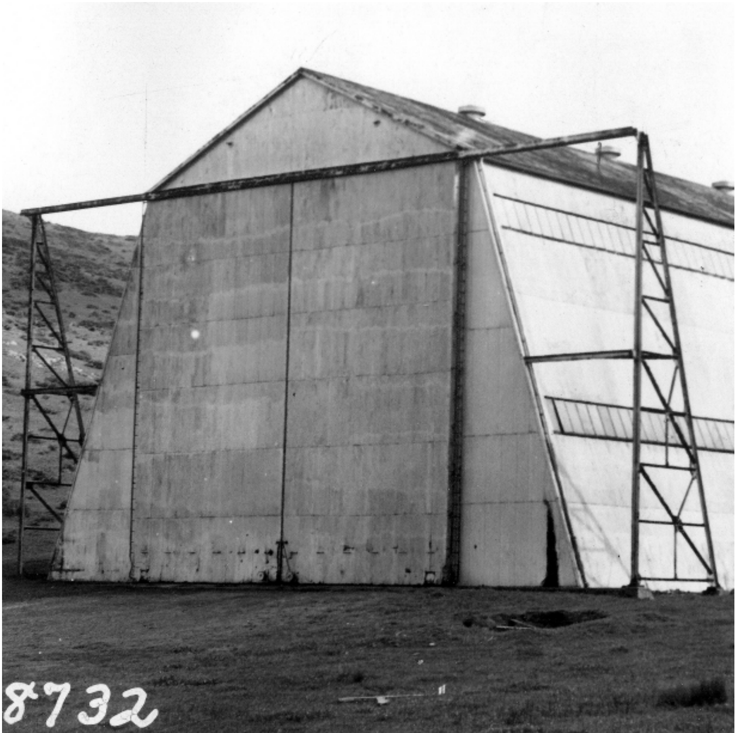
Fort Barry Balloon Hangar, 1939. (PARC, GOGA 32423)
