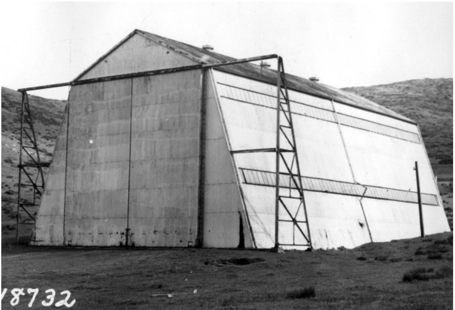
Fort Barry Balloon Hangar, 1939. (PARC, GOGA 32423)
